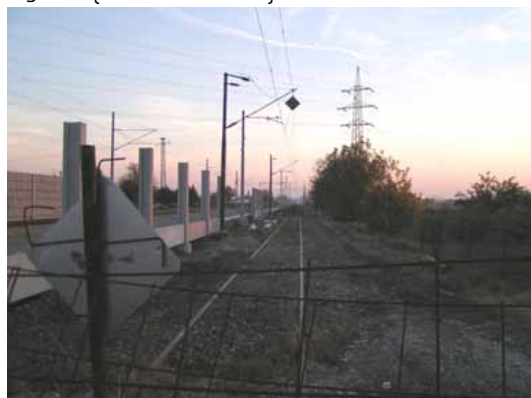
Ukončení bývalé výtažné koleje. {26.10.2006}
