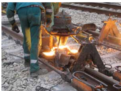
7) Tavenina vytéká z kotle
