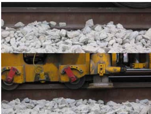
Fotografie téhož místa. Nahoře po podbití, dole před ním. Je zřejmé, že štěrk usedl. {18.11.2006}
