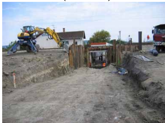
Jáma pro druhou rampu je již hotová. Vlevo „chodící bagr“ Kaiser S2-2. {27.9.2006}
