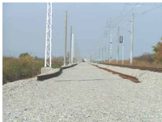
Pomocná drážka pro Donelli. Pravá kolejnice je již vyrovnaná, levá na to teprve čeká. {26.10.2006}
