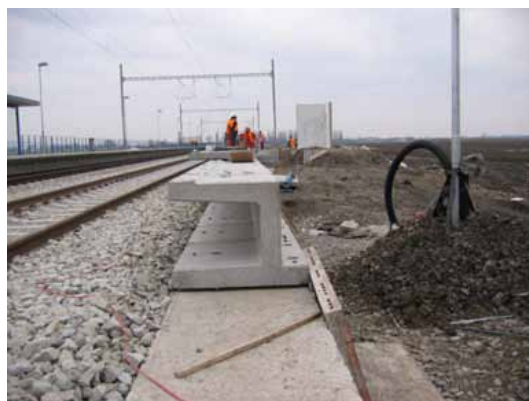
Vybetonovaný základ pro patu nástupiště. {26.10.2006}
