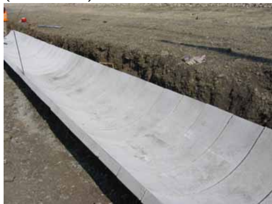
Betonové žlaby tvoří dna odvodňovacích příkop. {28.9.2006}
