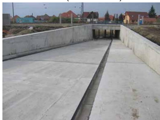
Sjezdová rampa. V žlabu bude odvodňovací vložka. {26.10.2006}
