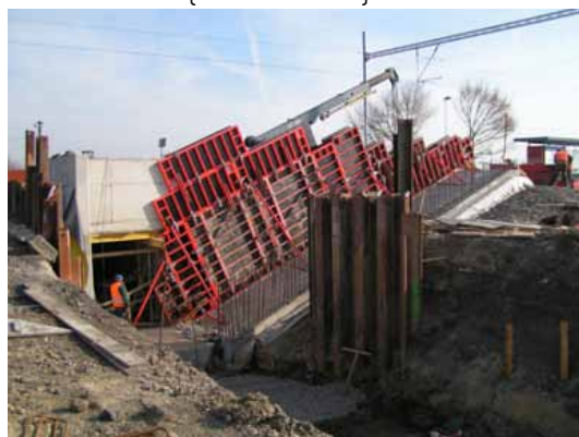
Právě probíhá betonáž stěny schodiště. {26.10.2006}
