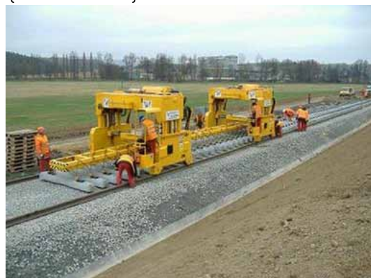
Donelli PTH 350 při práci na úseku trati Staňkov - Blížejev. {14.11.2005}
