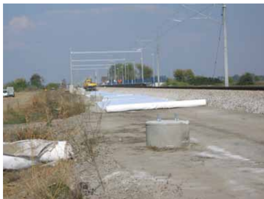
Pokládka Macritu na připravenou zemní pláň. {28.9.2006}
