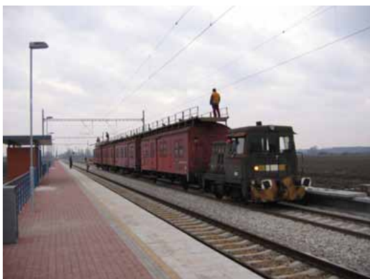
Montáž trakčního trolejového vedení v prostoru zastávky Madunice. {18.11.2006}
