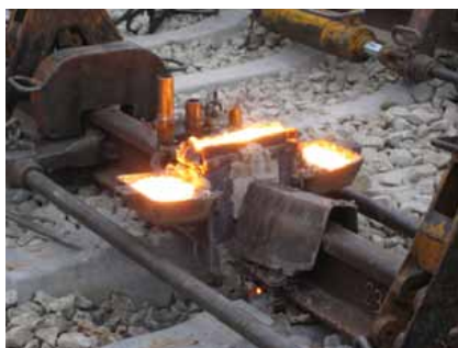
8) Kotel je odstraněn
