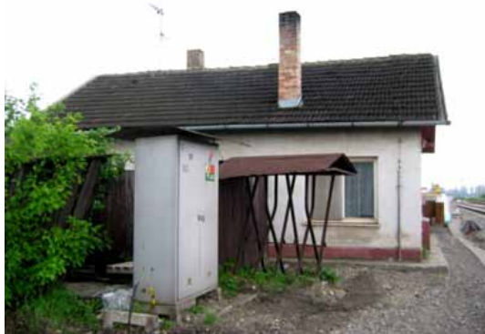
Pohled ze severu na stojan na kola. {12.5.2006}
