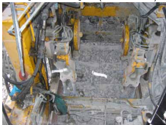
Pohled na podbíjecí ústrojí z kabiny obsluhy podbíječky. {18.11.2006}
