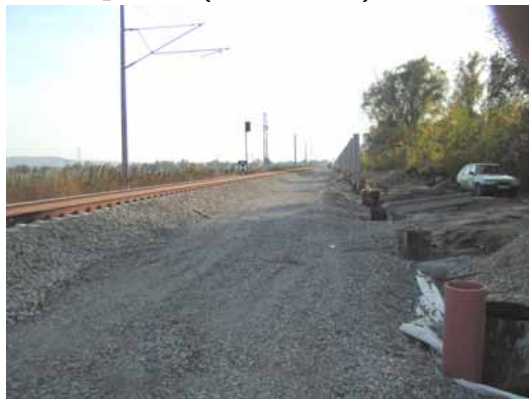
Připravené základy pro sloupy trolejového vedení {26.10.2006}
