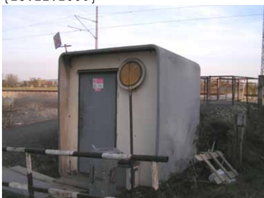
Strážní budka s návěstí 64a Výstraha. Strážný dbá na bezpečnost a ochranu zdraví při práci tím, že upozorňuje na přijíždějící vlak. {26.10.2006}
