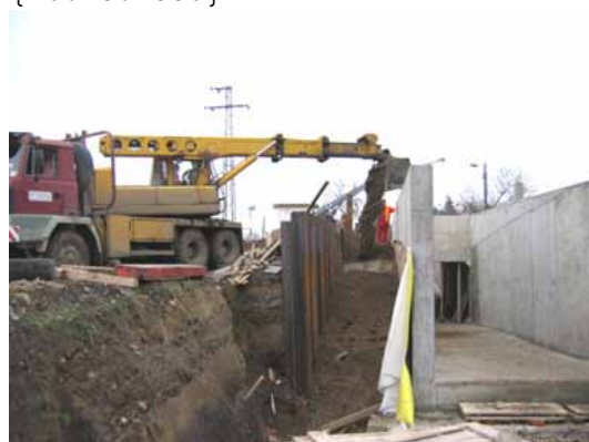
Zasypávání mezery mezi stěnou podchodu a pažením. {18.11.2006}
