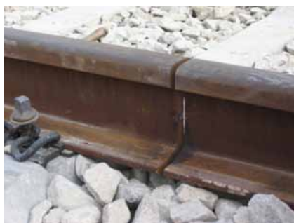
1) Kolejnice před svařením
