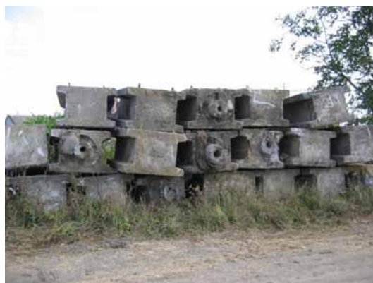
Vyřazené základy sloupů trakčního vedení u Madunic. {27.9.2006}
