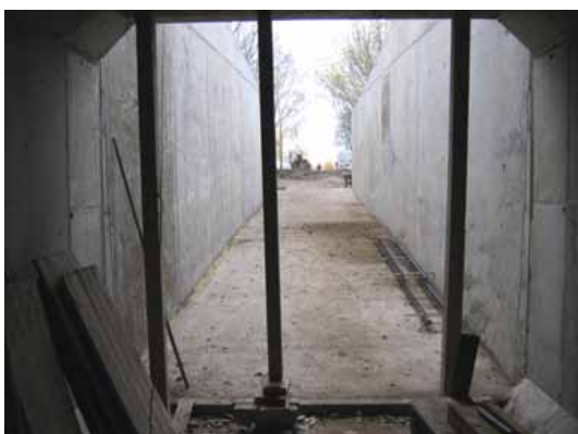
Armatura je zalita betonem. {18.11.2006}
