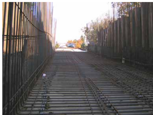
Armatura stěn a podlahy podchodu. {26.10.2006}
