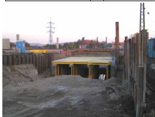
Bedně druhé části stropní desky Červeníku I. {26.10.2006}
